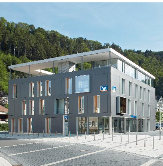
Die Volksbank – ein Referenzobjekt, das Metallbau Feuerbacher künftig bei der Akquise hilft.
